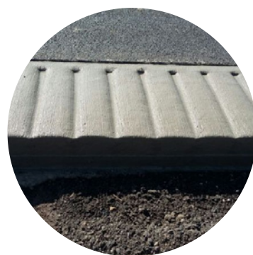
Overgangstrook met patroon, aangebracht met inprint/indruk sjabloon
