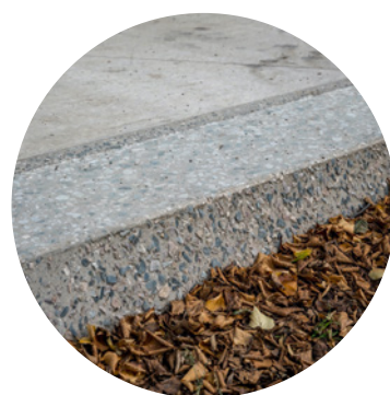
Kleur in-situ beton grijs voor randen, ingestrooid met donkere steenslag
