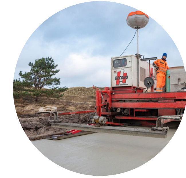
Voorbeeld aanbrengen in-situ betonpad in natuurgebied Texel
