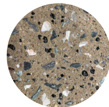
Langzame zone, overgangstrook en randen opruwen d.m.v. uitwassen/uitspuiten
