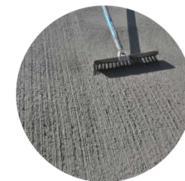
Overgangstrook licht geharkt afwerken
