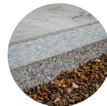
Kleur in-situ beton antraciet voor randen, ingestrooid met witte en grijze steenslag
