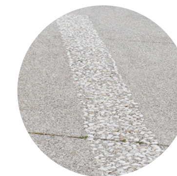
Kleur in-situ beton antraciet voor randen, ingestrooid met witte en grijze steenslag
