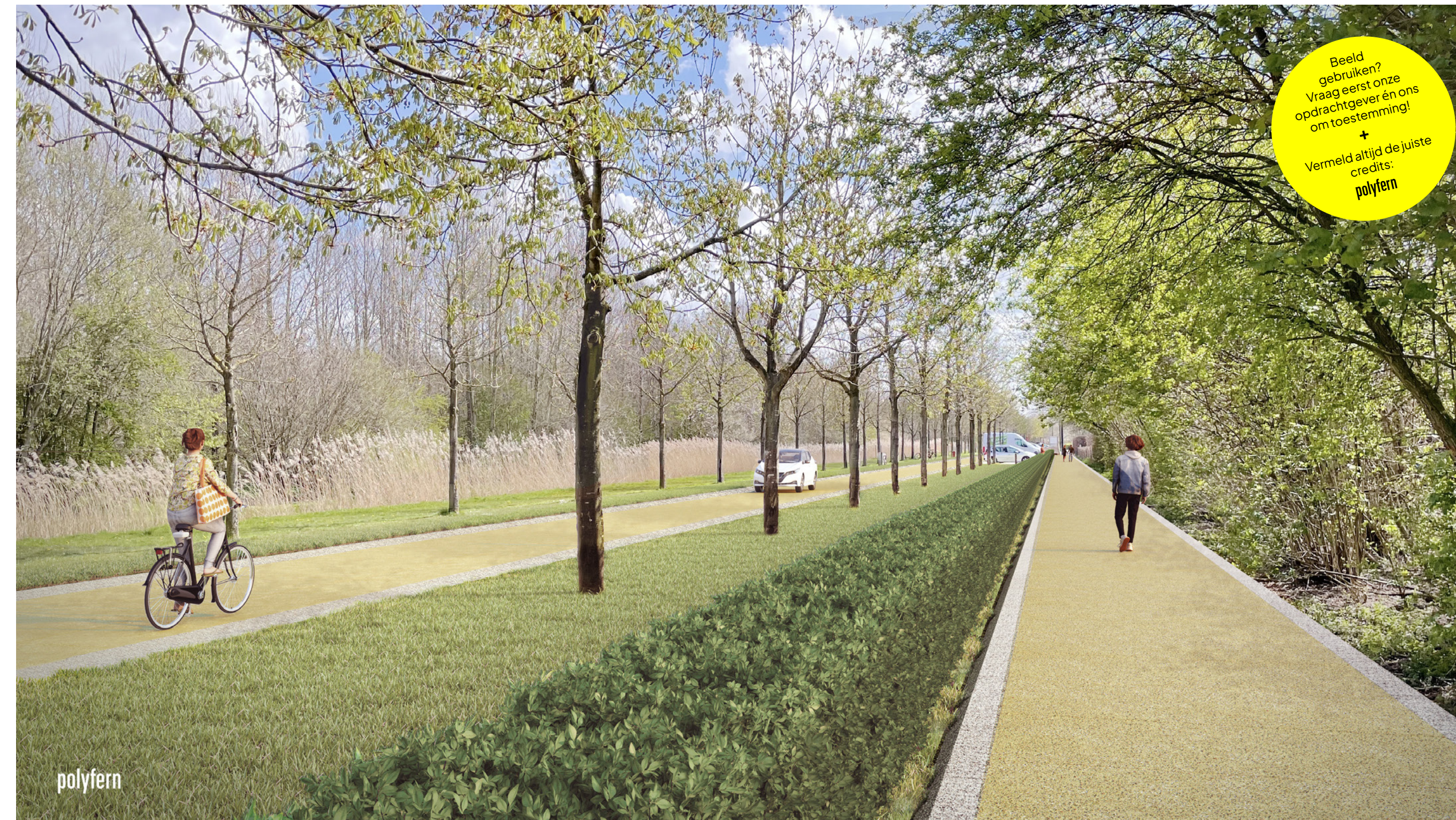
Impressie boscircuit over de Kemphaan (Kemphaanstraat). Gesplitst profiel waarbij de huidige rijbaan shared-space wordt in de materialisering van het circuit. Het voetgangersdeel van het circuit ligt op het huidige fiets/wandelpad. De delen zijn gescheiden door een haag.
