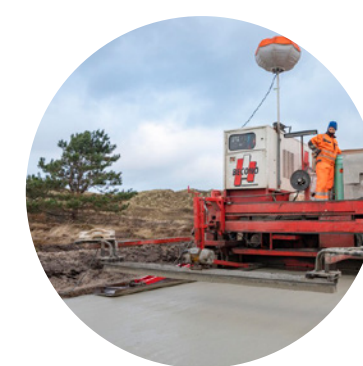
Snelle zone vlak gesmeerd aanbrengen
